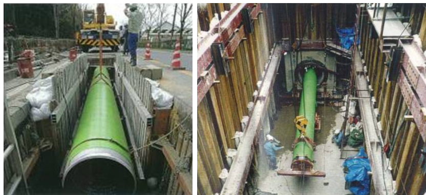
高圧幹線用ガス導管の埋設状況
