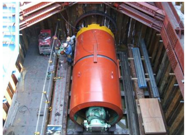
写真 現在工事中の幹線工事区間に使用するシールドマシン
