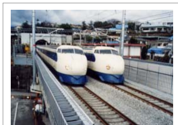
震災復旧(施設確認検査)
