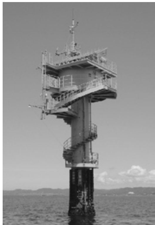
写真2 田辺中島高潮観測塔
