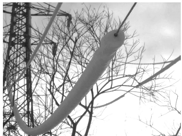
図1 筒雪化した過大な着雪[1]
