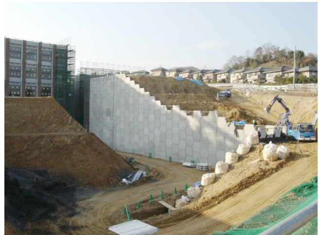
図1 Cクラスター建設時の様子（提供：ヒロセ補強土(株)）
