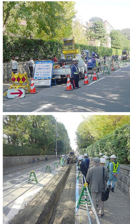
図1 「直接埋設方式」による無電柱化実証実験の風景
