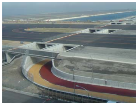
【関西国際空港 2期連絡誘導路全景】
